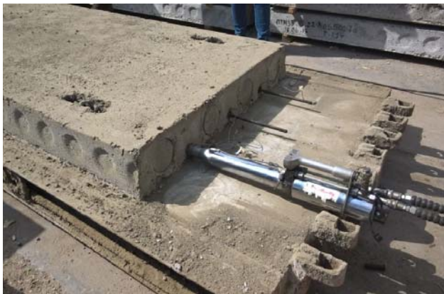
Рисунок 3 – Преднапряжение канатной арматуры экспериментальных плит
