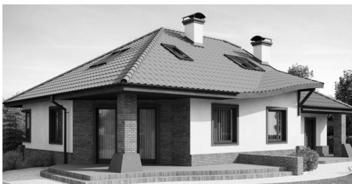
в) жилой дом с мансардными окнами
